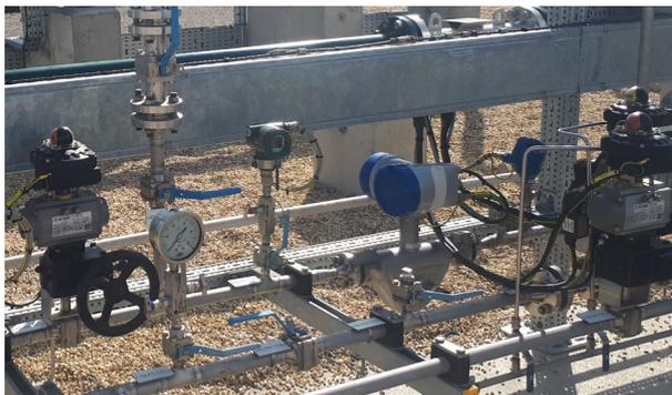
Durchflussmessung von Wasserstoff und SNG mit dem OPTIMASS 6400
