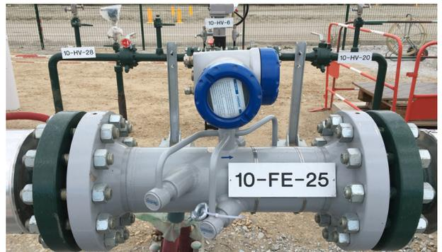
Ultraschall-Durchflussmessgerät OPTISONIC 7300 vor der Inbetriebnahme
