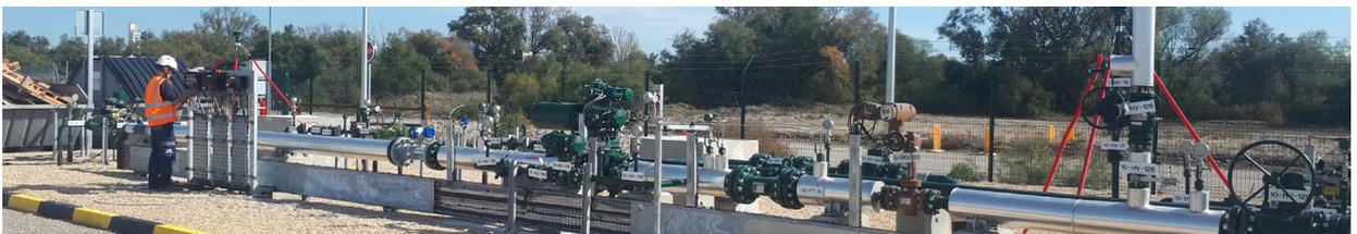
OPTISONIC 7300 C: Ultraschall-Durchflussmessung von Erdgas aus dem Gasnetz
