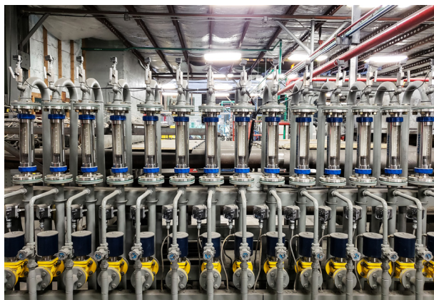
Wasserstoffdurchflussmessung mit dem Schwebekörper-Durchflussmessgerät VA 40
