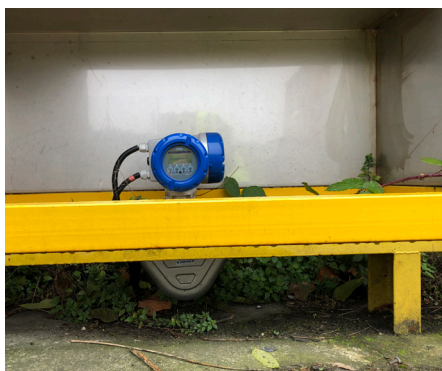
Messung des Gesamtverbrauchs an Wasserstoff mit dem Coriolis Masse-Durchflussmessgerät OPTIMASS 6400 (DN15)
