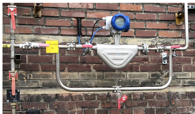
Wasserstoffmessung bei MERSEN mit dem Coriolis Masse-Durchflussmessgerät OPTIMASS 6400 (DN10)
